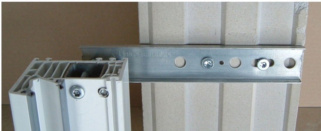
Fenster in der Dämmschicht
