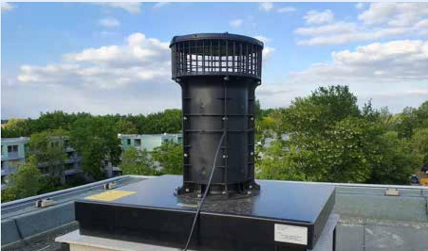
Mithilfe des individuell gefertigten Aluminium-Dachsockels wird das Niederdruck-Hybridlüftungsgerät DVND 315 auf dem Schacht angebracht.
