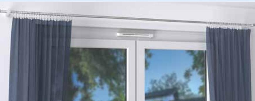
Die Nachströmung der frischen Luft erfolgt über die feuchtegeführten Außenbauteil-Luftdurchlässe in den Wohn- und Schlafräumen. Hierfür können zum Beispiel ALD für den Fenstereinbau (Abbildung links) eingesetzt werden. Dank der integrierten Feuchteerkennung strömt die Frischluft vor allem in die Räume mit einem höheren Belüftungsbedarf.
