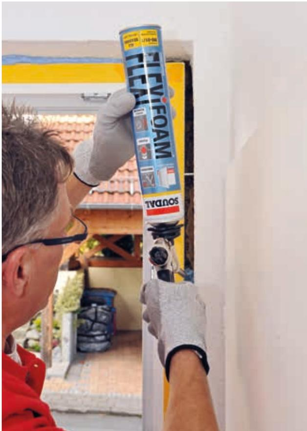
Durch vollständiges Ausfüllen des Hohlraumes zwischen Fensterrahmen und Baukörper wirkt die Funktionsebene wärmedämmend und schallreduzierend. Dank hoher Elastizität nach der Aushärtung kann der flexible Schaum Fugenbewegungen perfekt aufnehmen, ohne Risse zu bilden. Er ist somit langlebig und gewährleistet eine dauerhaft optimale Funktionalität.
